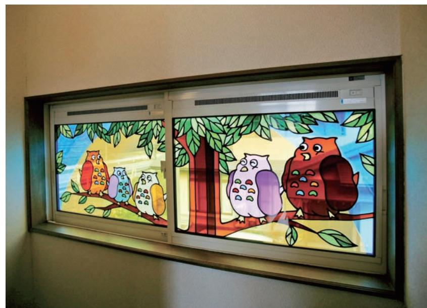
給気プレスとステンドグラスを組み込んだサッシ窓
