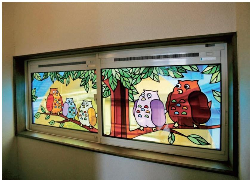
給気プレスとステンドグラスを組み込んだサッシ窓
