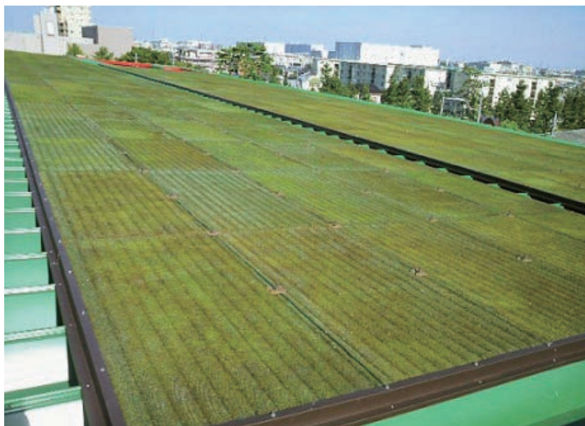
屋上に敷き詰められたコケボードは直射日光による室温の上昇を抑制する
