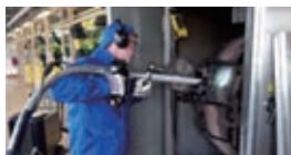
配管等のジェット洗浄の様子
