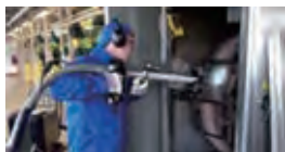
配管等のジェット洗浄の様子
