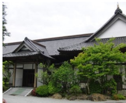
図 2.3 川内村事務所
