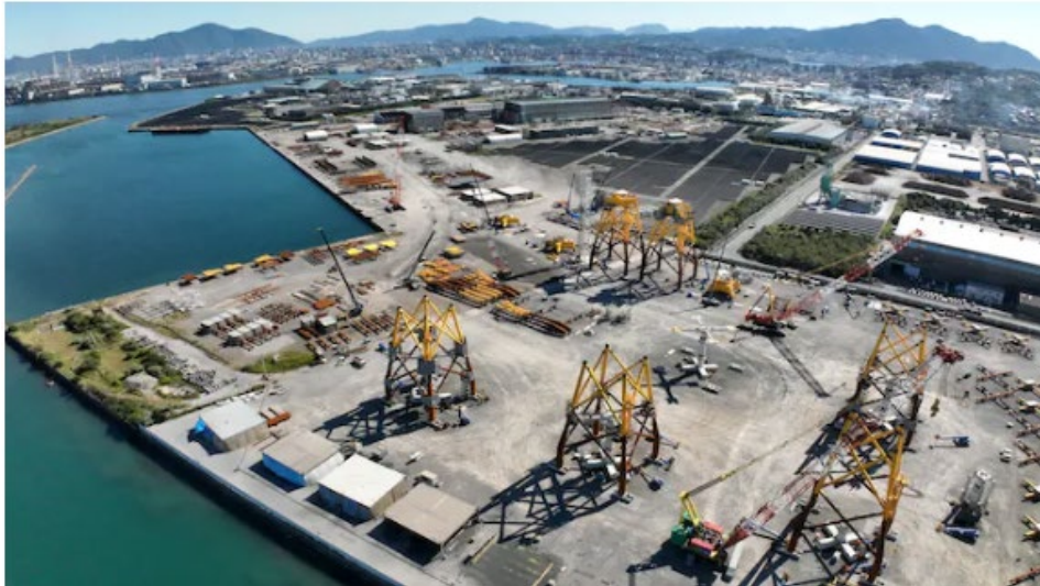
図 6-11 港湾地区におけるジェット部の製造 (出典：日鉄エンジニアリング)
