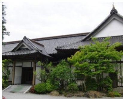
図 2.2 川内村事務所
