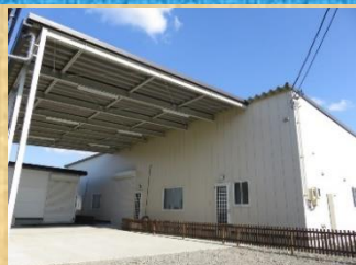
新設した第5工場の外観
