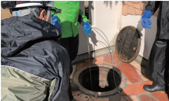
配管調査の様子
