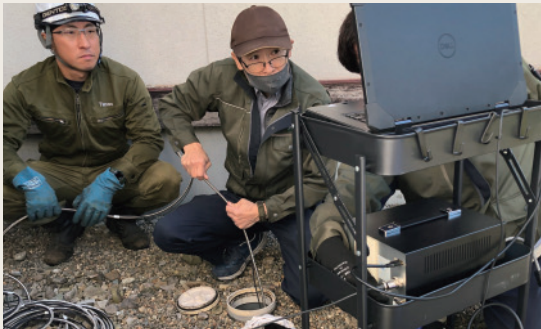
管内の様子を確認しながら作業を進める
