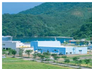
マリンテック釜石工場
