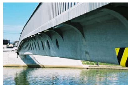
コンクリート使用例
