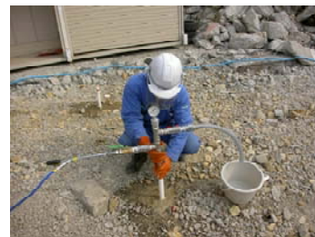
フェントン反応剤注入
