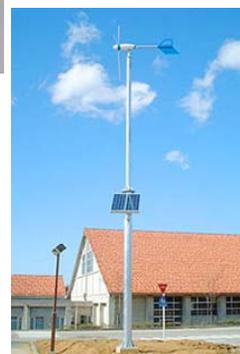
太陽光発電パネル併用ハイブリッド型風力発電
