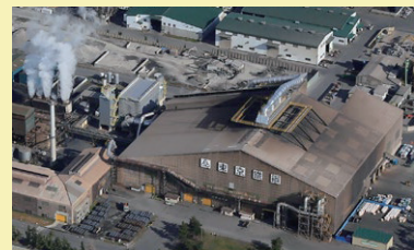
東京鐵鋼株式会社 八戸工場 製鋼棟
