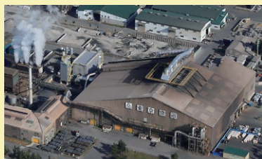
東京鐵鋼株式会社 八戸工場 製鋼棟
