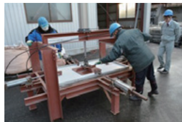
パネル外枠を分離
