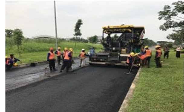
インドネシアでのリサイクルアスファルトの舗装状況
