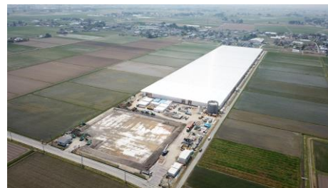
【美里町グリーンベース（建設中）】
