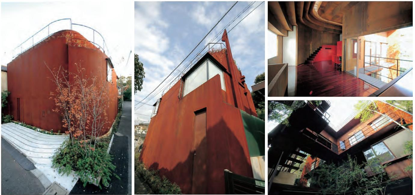
◆コルテン鋼を屋根・外壁・内装の全てに用いた事例
