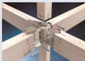
KES構法イメージCG 最大の弱点である接合部に金物を用い、耐震性と設計自由度を高めた
