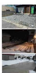
地中熱利用 融雪・凍結防止 システム施工事例
