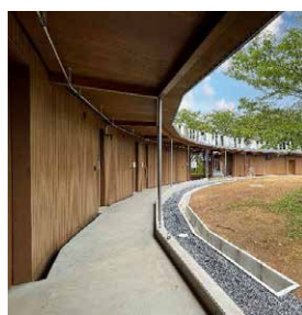
パネルログ構法による建物
