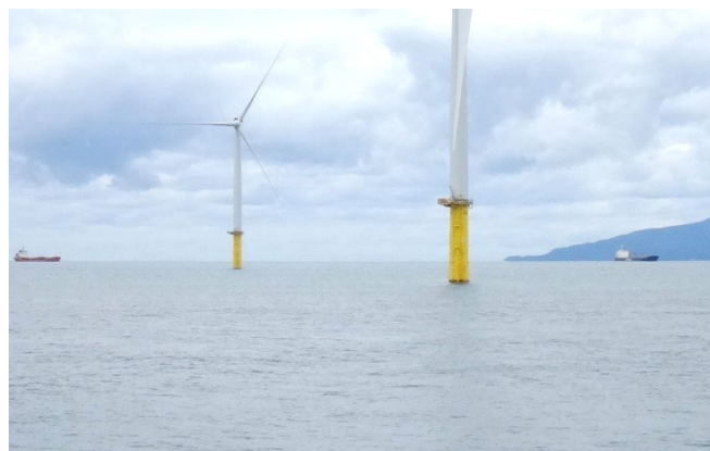
図 2-25 トランジションピース（黄色の部分）
