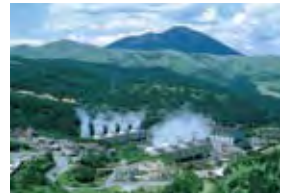
八丁原地熱発電所(大分県九重町)
