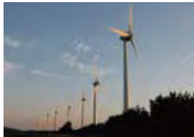
能代風力発電所(秋田県能代市)
