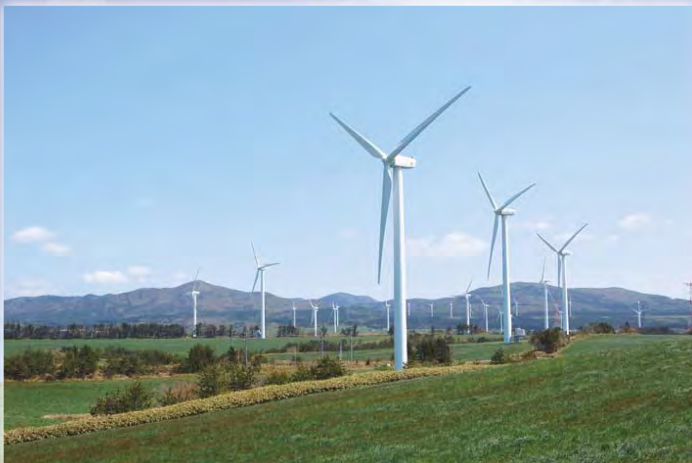
(六ヶ所村二又風力発電所)
