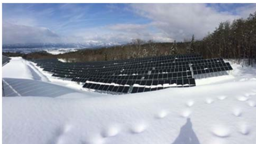
積雪に対応した工法
