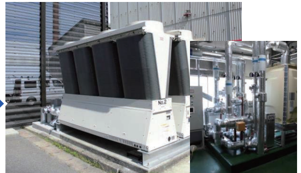
上：新規空冷チラー、右：熱交換器
