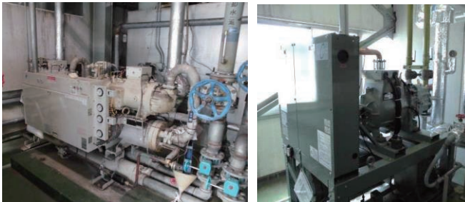
水冷式チラー（左：20℃冷水用、右：10℃冷水用）
