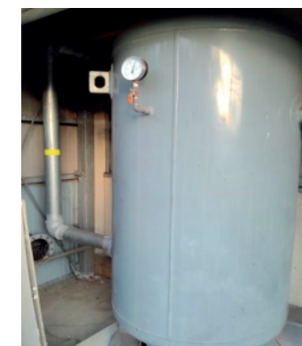
末端室外部に設置されたレシーバタンクと新設配管（φ100）
