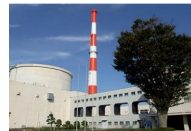
高速実験炉「常陽」
