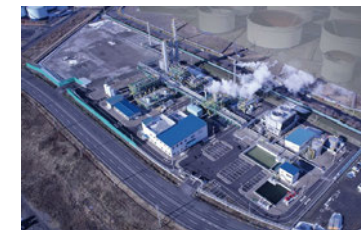
CO2分離・回収・貯留施設
