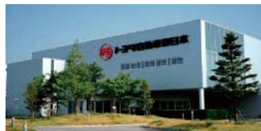
トヨタ自動車東日本(株)本社・宮城大衡工場
